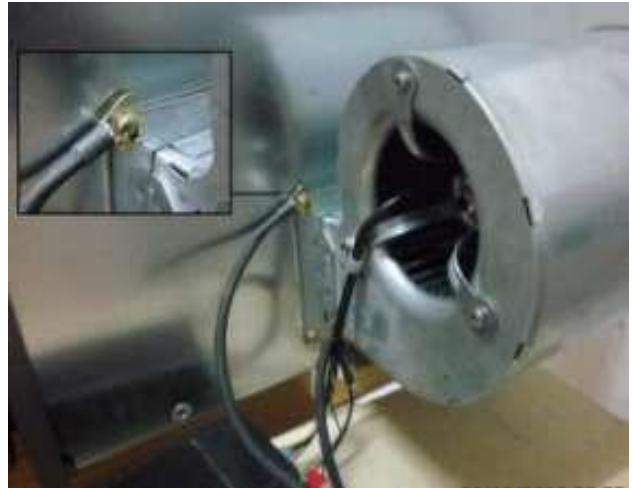
Rys. 9 Po lewej: fan okno w pozycji 2 lub 3, z antywibracyjnym śrubą zainstalowaną. Rysunek 9 right: fan związany wokół okna z sondą NTC złowionych między śrubą a ramą wentylatora
